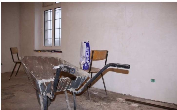
Remont nowych pomieszczeń
